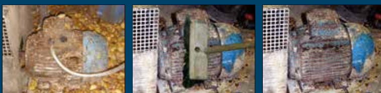
Vor der Reinigung Während der Reinigung Nach der Reinigung
